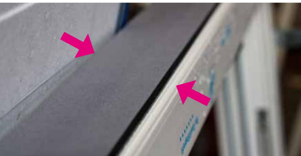
Neimpregnovaný měkčený materiál po obou stranách pásy výrazně usnadňuje odvíjení, tvarování a zkracování pásy. Zároveň omezuje nežádoucí protažení pásy při montáži. Impregnovaná (černá) část pásy obsahuje nelepivou impregnaci a tudíž neznečišťuje nástroje.
